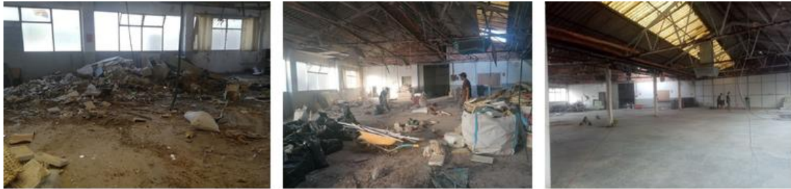
Proceso de adecuación del centro social CSOA Trencalòs. Fuente: Fotografía cedida por E2 en la entrevista (2026).
